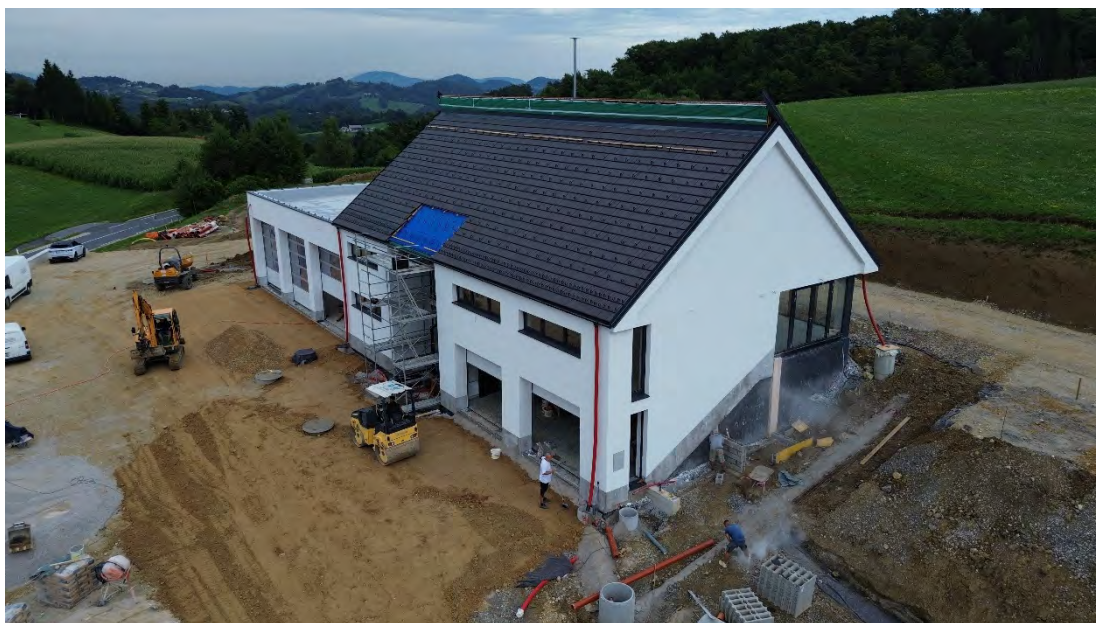
Gradnja gasilskega doma na Planini pri Sevnici
