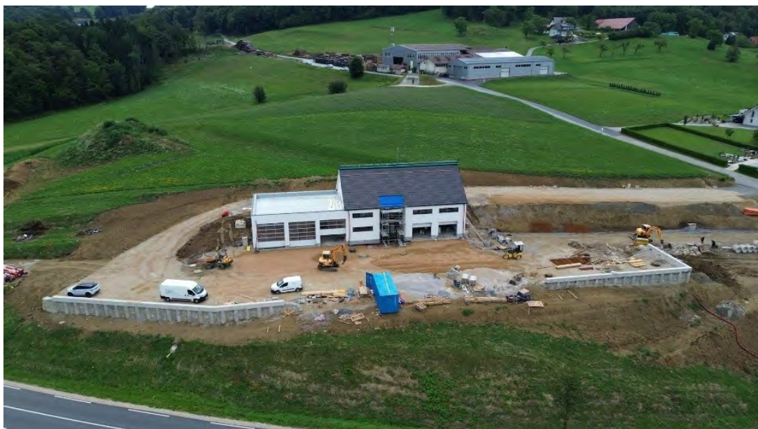
Gradnja gasilskega doma na Planini pri Sevnici
